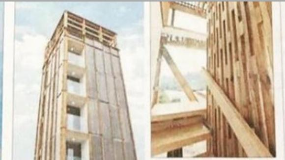
La Torre Experimental Peñuelas tiene 16 metros. Se someterá durante un año a distintas variables para conocer el comportamiento de la madera en altura.
